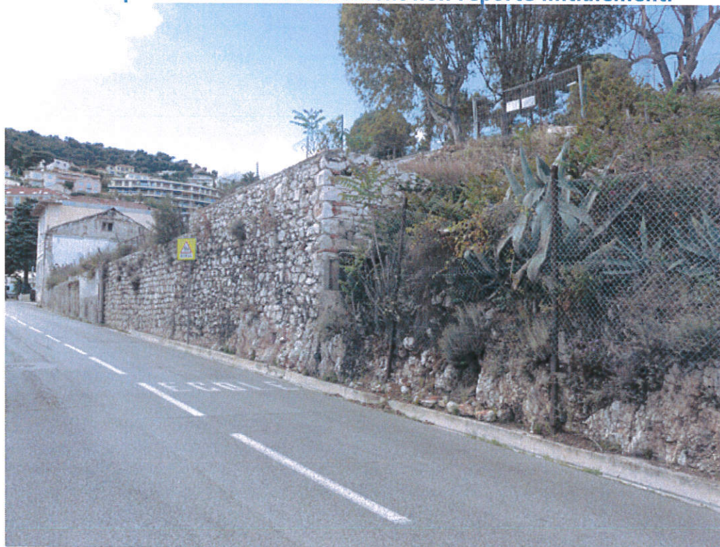
Mur de soutènement limitant les « rochers et talus végétalisés » le long de l'avenue Général de Gaulle
